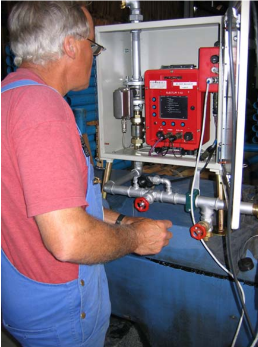
Druck-/Mengenmessgerät Injektlim 4G im Einsatz
